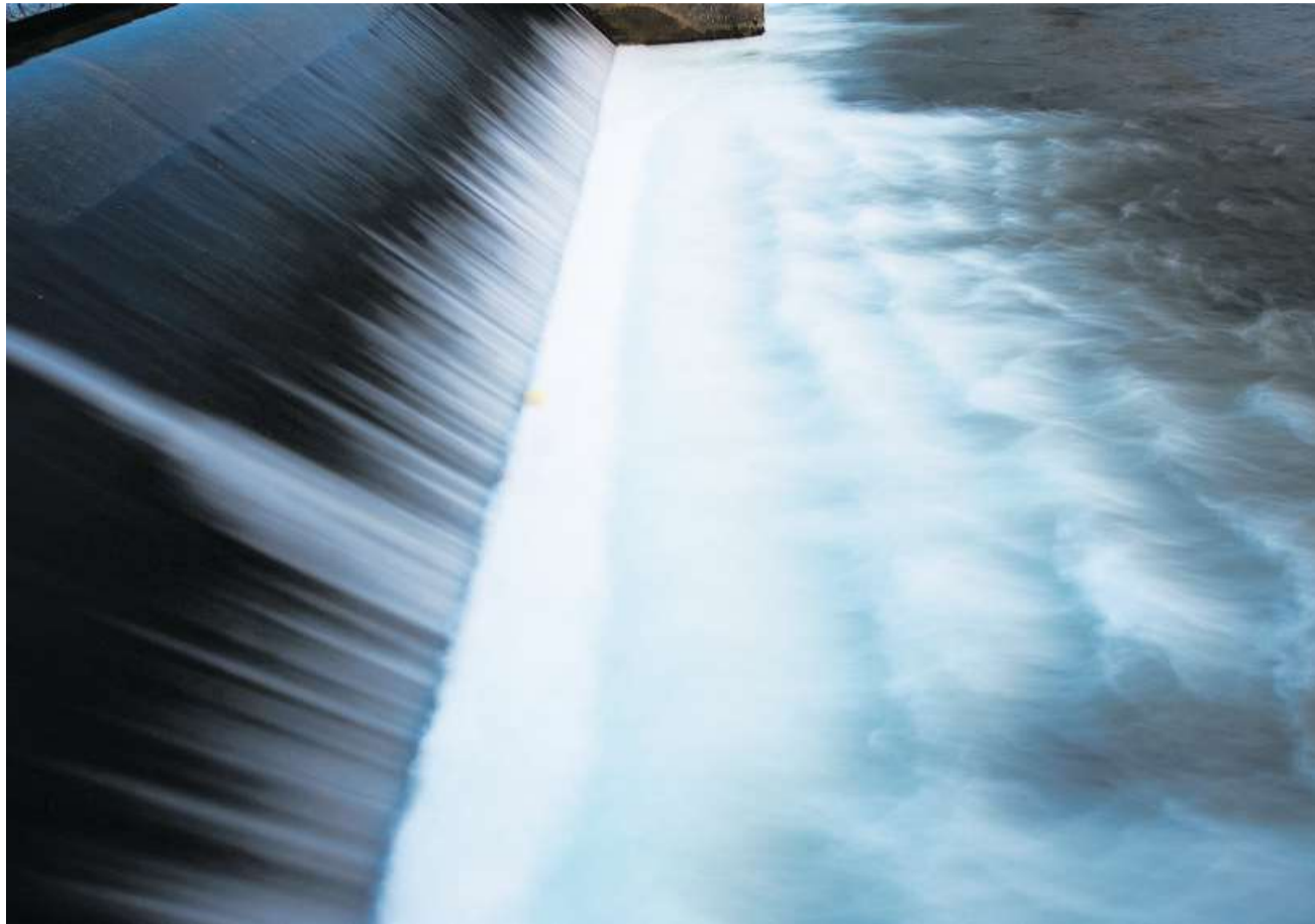
Der Strombedarf in der Schweiz schwankt stark – auch Wasserkraft kann dies nicht ausgleichen.
